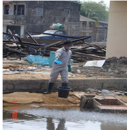
รูปที่ 2.6 การเตรียมปริมาณคลอรีนและการโปรยคลอรีน
