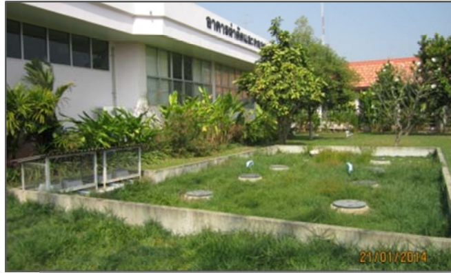
รูปที่ 1 ระบบบำบัดน้ำเสียชุดที่ 1 ด้านขวาของอาคารผ่าตัดและคลอด
