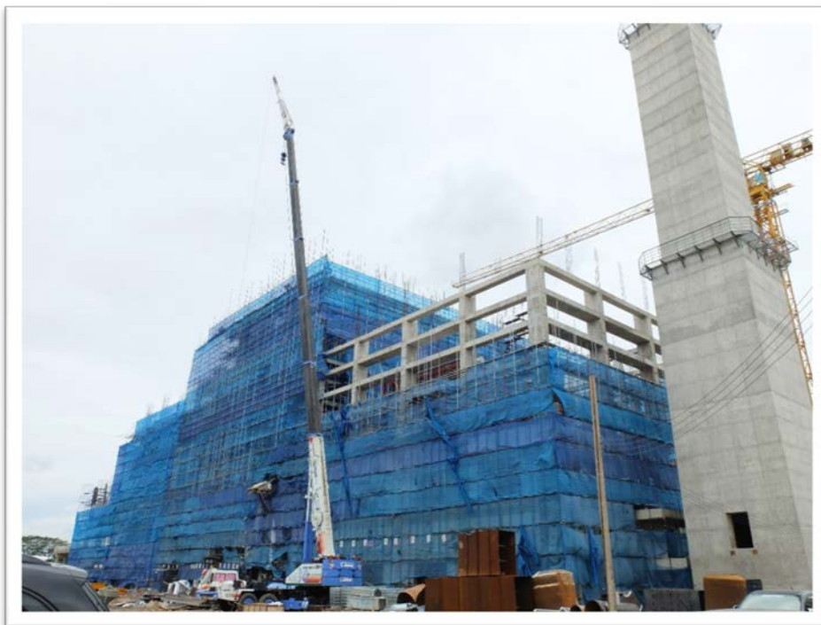
ภาพที่ 8 การก่อสร้างระบบเตาเผาขยะมูลฝอย ณ ศูนย์จัดการขยะมูลฝอยหนองแถม
