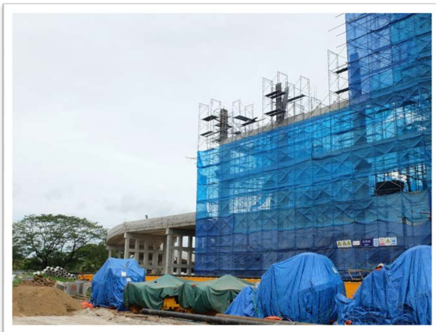
ภาพที่ 3 ทางเข้า - ออก สู่อาคารบ่อพักขยะมูลฝอย
