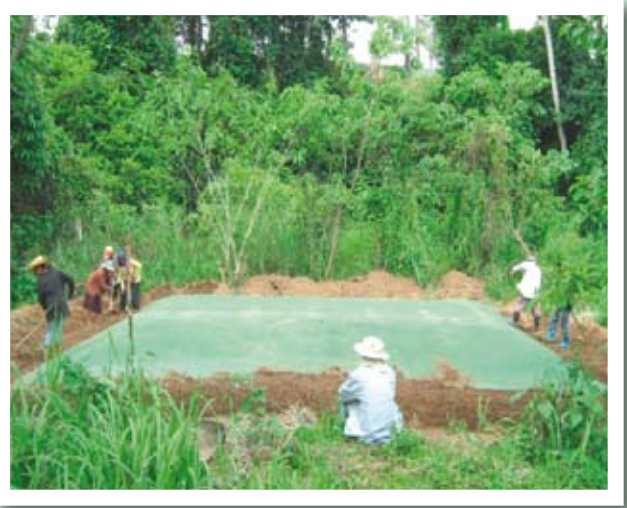
ปู Geo-membrane HDPE
